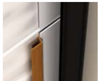
Устанавливаем боковой профиль под правую боковую крышку нижней сэндвич-панели.
