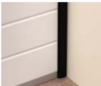
Отгибаем мягкую часть бокового уплотнителя с правой стороны нижней сэндвич-панели.
